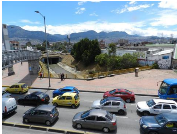
Fotografía 5.2.2.3 Vista del Canal el Fucha desde el puente peatonal de la estación SENA de Transmilenio
