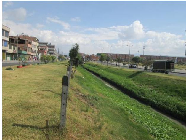
Fotografía 5.2.2.2 Aspecto del Canal Tintal II en el sector del Portal de las Américas de Transmilenio
