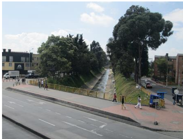
Fotografía 5.2.2.4 Vista del Canal Fucha hacia el occidente
